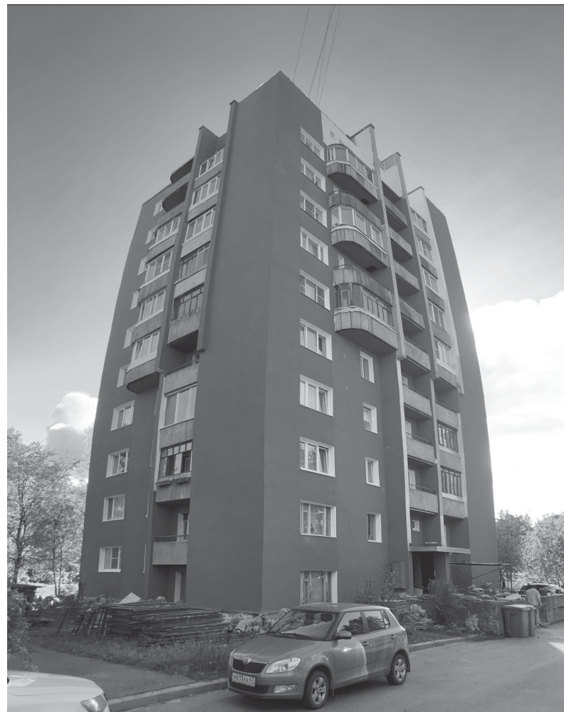
Сосновый Бор. Завершение капремонта на ул. Героев, 11
