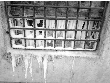
Прорыв канализации в подвале дома №4А по Лесной улице
