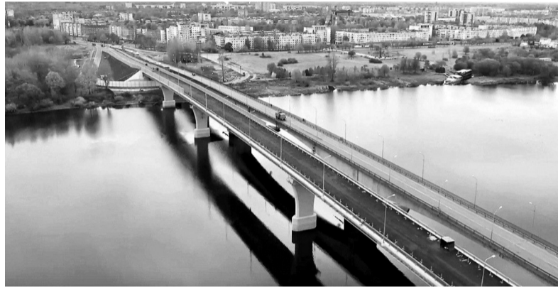
В марте было открыто движение по мосту-гиганту на въезде в Кириши
