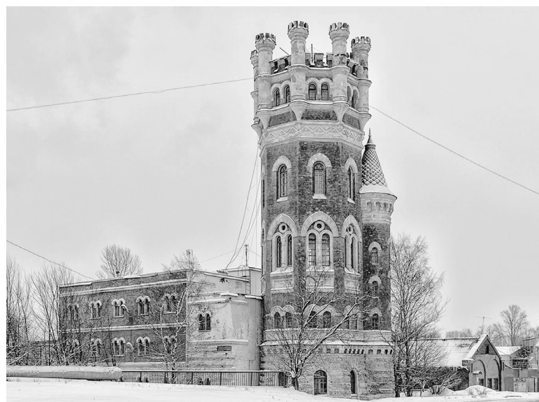
Водонапорная башня Обуховского завода (Октябрьская наб., 104А, на противоположном от музея берегу). Построена в 1899 г. Имела двойное назначение: помимо хранения запаса воды, здание использовали для пристрелки выпущавшихся на заводе орудий
