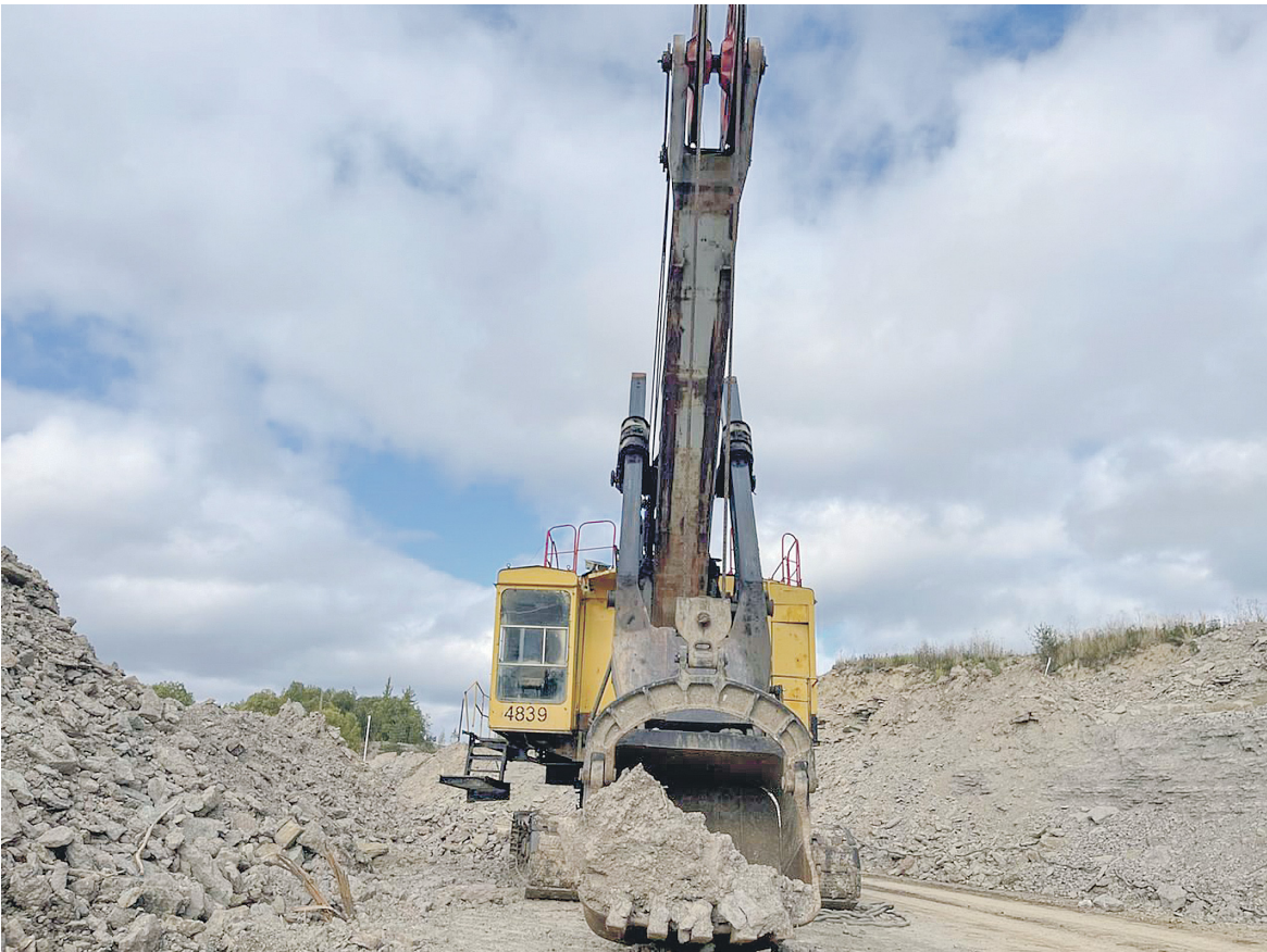
Работы на Путиловском карьере
