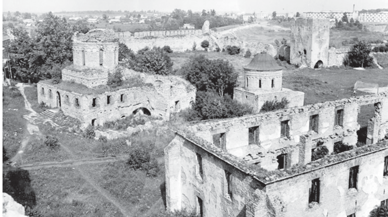
В годы Великой Отечественной войны памятнику был нанесен огромный урон: из 11 башен взорваны 6, разрушены участки стен, разрушены и сожжены почти все внутрикрепостные постройки /фото iren-haustova.ru/
